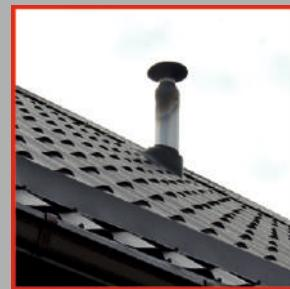
Провести осмотр оголовков дымовых труб и каналов дымоходов и убедиться в отсутствии их обмерзания и закупорки.
